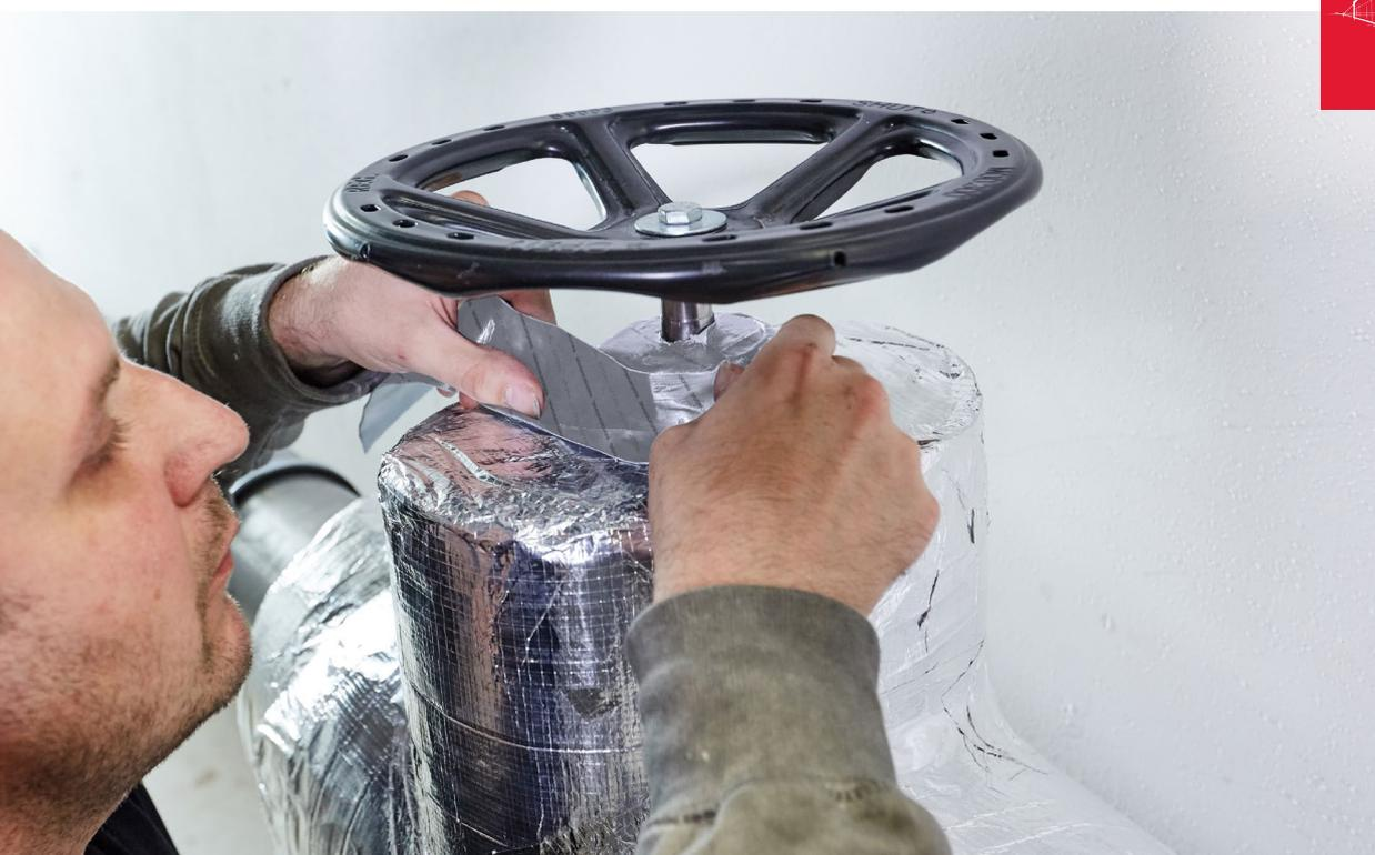
Das ROCKWOOL TECLIT Flextape ist ein hochwertiges Dichtband für die Verklebung von Dämmstoff-Stoßstellen, die hohe Flexibilität und Festigkeit aufweisen müssen. Es besitzt eine sehr hohe Haftfähigkeit und ist sehr elastisch. Damit eignet es sich besonders für die Abdichtung von Verbindungen und Durchdringungen von Kälte-dämmungen an haustechnischen Anlagen mit dem TECLIT System.
