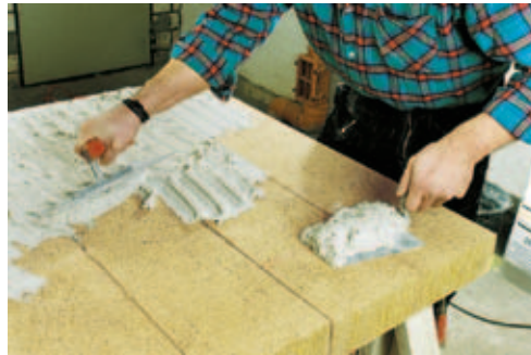
Der Kleber wird mit einer Zahnpachtel vollflächig auf den Dämmstoff aufgetragen.
