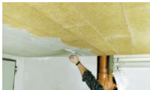
Die Sichtseite von Planarock erfordert keine weitere Behandlung. Auf Wunsch kann jedoch ein Farbanstrich oder eine dünne Spachtelschicht aufgetragen werden.
